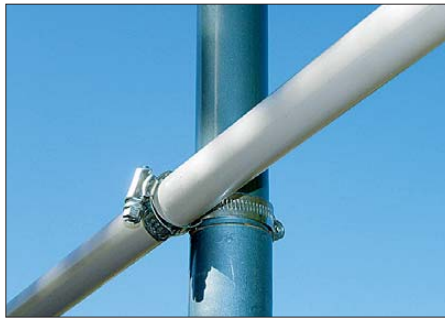
Bild 12: Befestigung des Querträgers aus Installationsrohr am Teleskopmast
