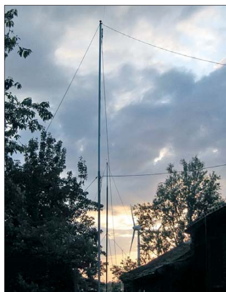
Bild 6: Als Sendeantenne dient HCJB Weenermoor ein leicht abgewinkelter Halbwellendipol.
