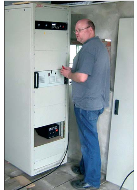
Bild 3: Stephan Schaa an der aktuellen KW-Sendeanlage beim Exciter-Test. In mittlerer Höhe ist der Einschub mit dem 1,5-kW-Sender zu sehen.
